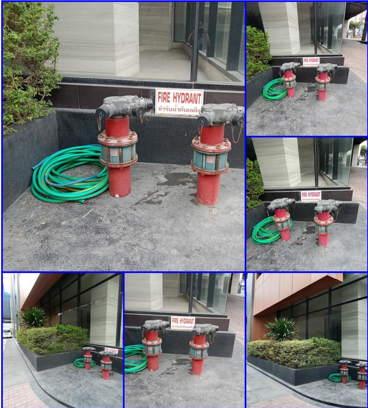
รูปที่ 12.28 ห้รับน้ำดับเพลิงภายนอกอาคาร (Fire Department Connector : FDC)
