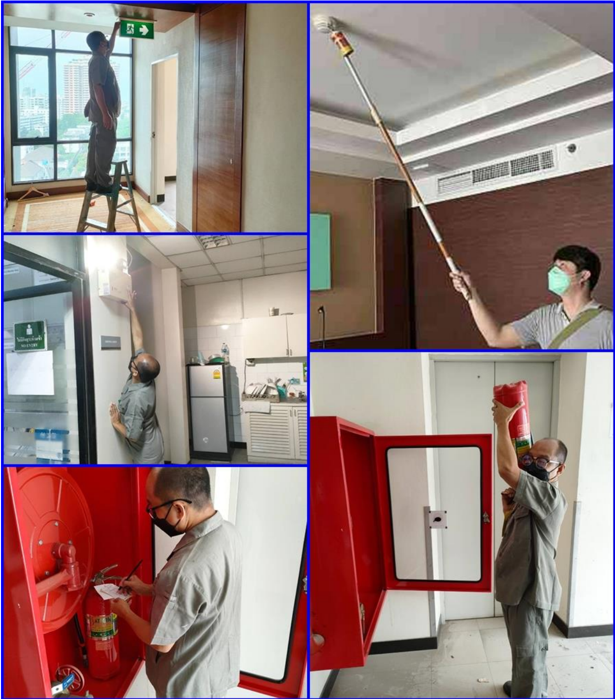
รูปที่ 12.40 ตรวจสอบระบบป้องกันและเตือนอัคคีภัยให้สามารถใช้งานได้อยู่เสมอ
