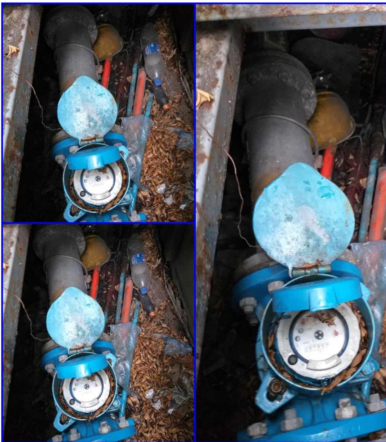
รูปที่ 12.13 รับน้ำประปาจากท่อจ่ายน้ำประปาของการประปานครหลวงมาเก็บในถังเก็บน้ำใต้ดิน ของโครงการ ด้วยการต่อท่อระบบน้ำประปาขนาด 4 นิ้ว
