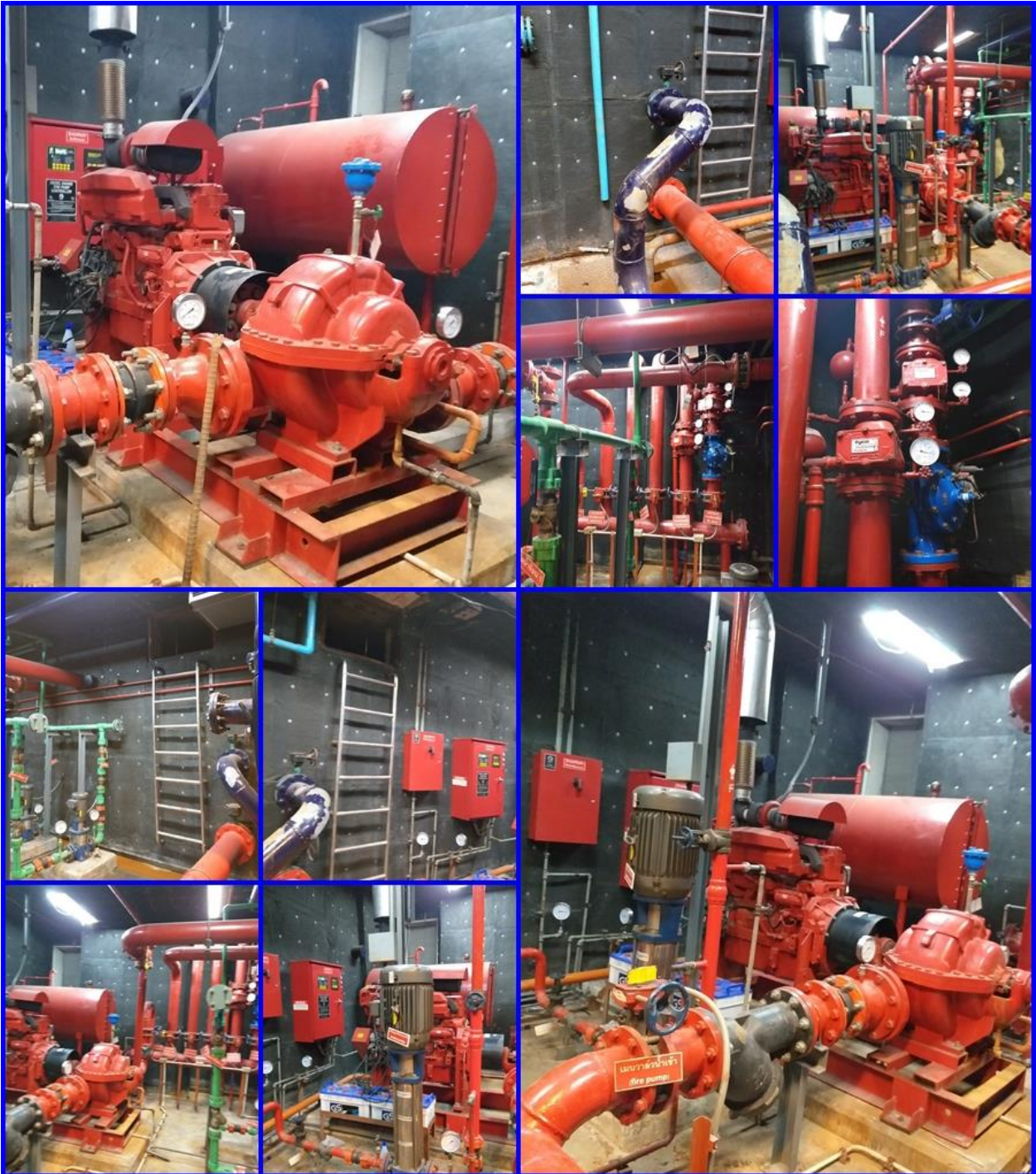
รูปที่ 12.26 ระบบท่อยืน ประกอบด้วย ท่อยืน (Stand Pipe) ขนาดเส้นผ่านศูนย์กลาง - 6 นิ้ว จำนวน 2 ท่อ
